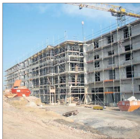
Der Rohbau für das Senioren-Servicehaus steht. Am Montag ist Richtfest.
